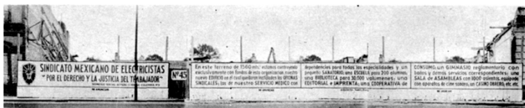
Figura 3. Vista del terreno donde se construiría el edificio contenedor del mural, calle de Las Artes 45 (hoy Antonio Caso 45, Colonia Tabacalera), autor desconocido, s/f, colección particular.
