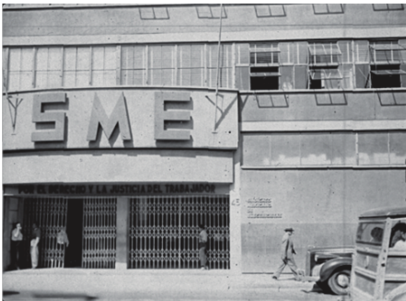
Figura 5. Fachada original del edificio sindical, Alcalá, s/f, emulsión de plata, colección particular.
