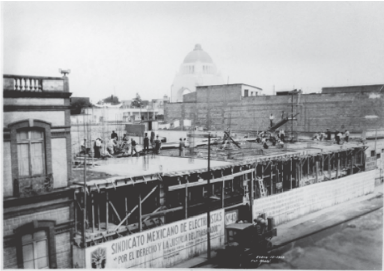
Figura 2. Vista de los trabajos de construcción del edificio sindical, Alcalá, enero 13 de 1938, colección particular.
